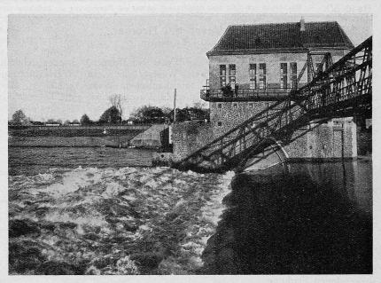
Abb. 8. Wehr gesenkt bei hohem Unterwasser (Flut). (8. II. 1911).
