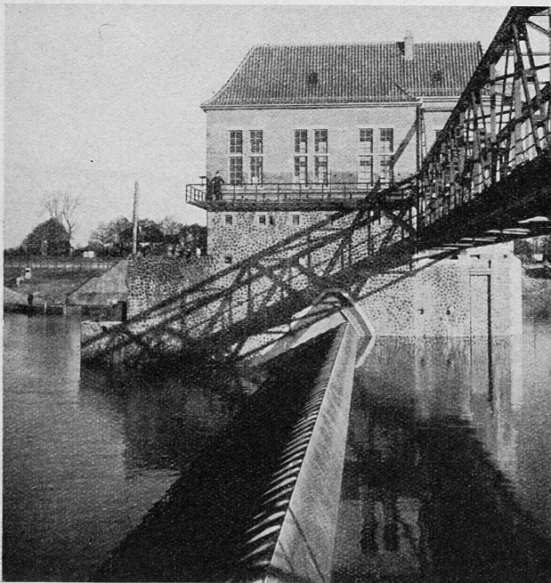
Abb. 7. Ueber den Stauspiegel gehobenes Wehr.
