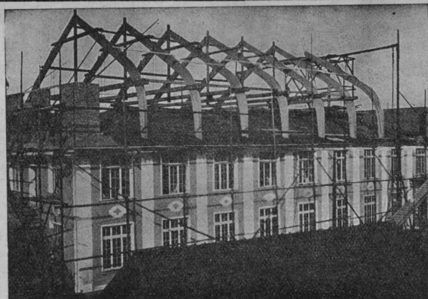
Stockwerksaufbau einer Fabrik nach Hetzer'scher Bauart.
