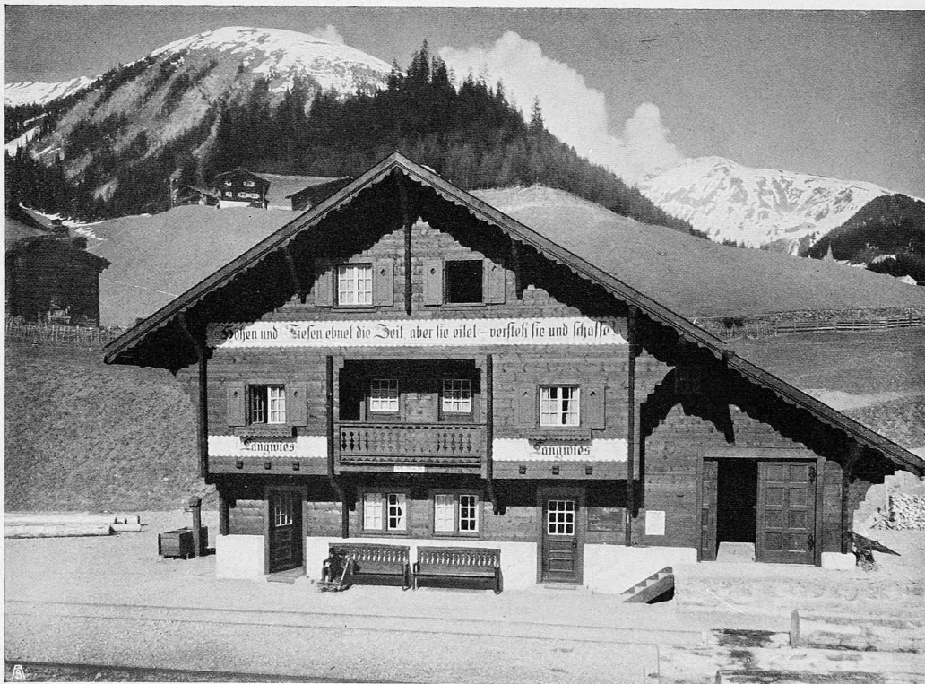
STATIONSGEBÄUDE LANGWIES DER CHUR-AROSA-BAHN
