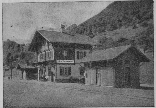
Station der Brienerseebah Eternit-Doppeldach, kupferbraun.
