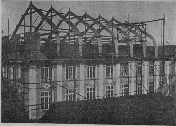
Stockwerksaufbau einer Fabrik nach Hetzer'scher Bauart.
