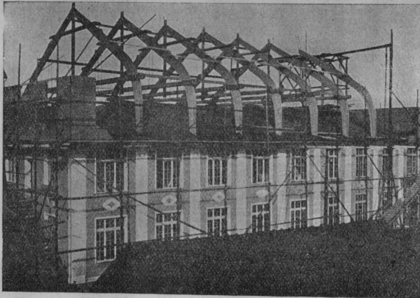
Stockwerksaufbau einer Fabrik nach Hetzer'scher Bauart.
