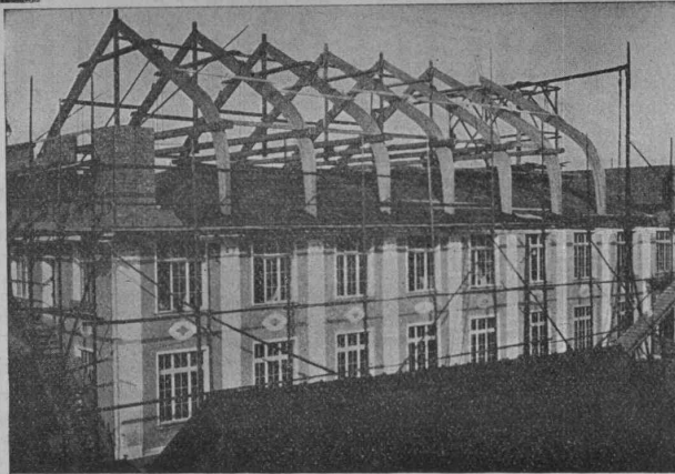
Stockwerksaufbau einer Fabrik nach Hetzer'scher Bauart.
