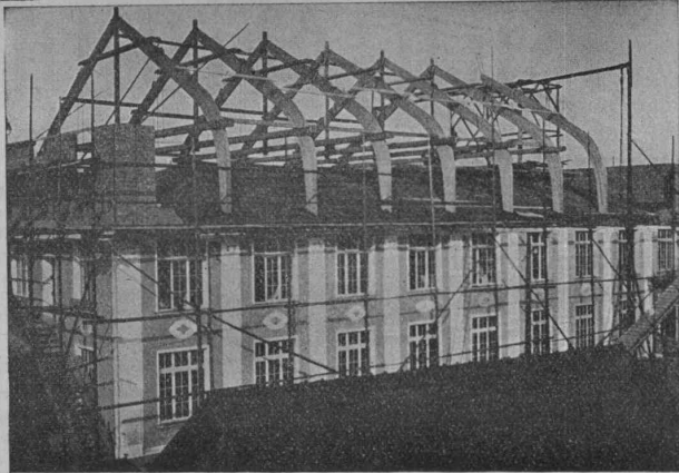
Stockwerksaufbau einer Fabrik nach Hetzer'scher Bauart.
