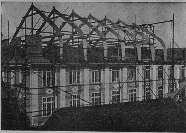
Stockwerksaufbau einer Fabrik nach Hetzer'scher Bauart.
