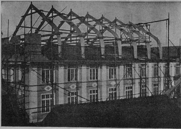
Stockwerksaufbau einer Fabrik nach Hetzer'scher Bauart.
