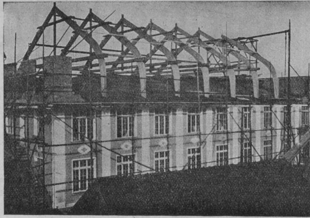
Stockwerksaufbau einer Fabrik nach Hetzer'scher Bauart.
