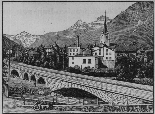
Eisenbahnbrücke ü. d. beiden Lintharme i. Schwanden
