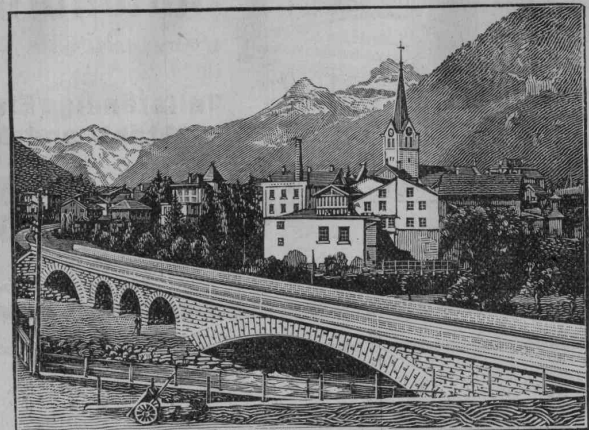
Eisenbahnbrücke ü. d. beiden Lintharme i. Schwanden
