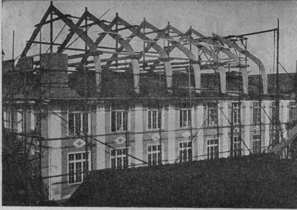
Stockwerksaufbau einer Fabrik nach Hetzer'scher Bauart.
