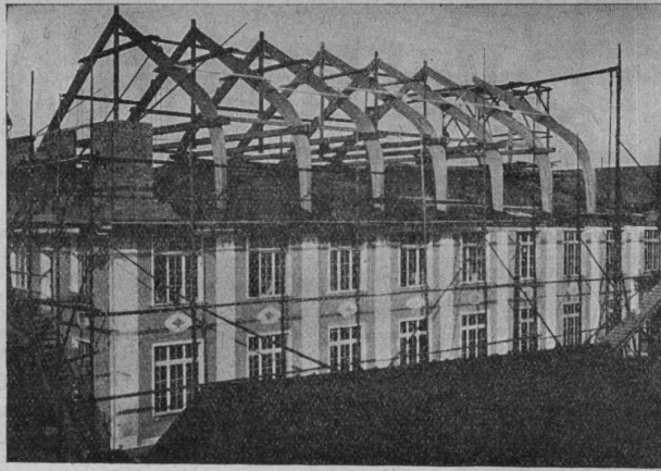
Stockwerksaufbau einer Fabrik nach Hetzer'scher Bauart.
