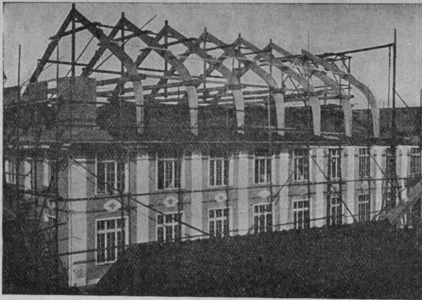
Stockwerksaufbau einer Fabrik nach Hetzer'scher Bauart.
