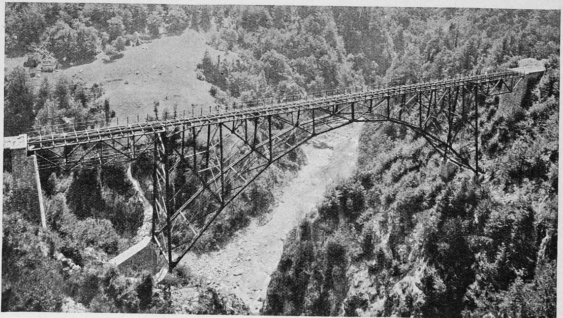
Abb. 2. Die Ruinacci-Br cke bei Camedo an der Centovalli-Bahn, nach Vollendung der Eisenkonstruktion.
