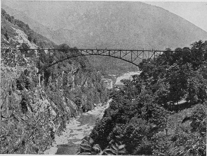
Abb. 1. Gesamtansicht der Isorno-Brücke bei Intragna. Ausführung beider Brücken: Löhle & Kern, A.-G. für Eisenbau, Zürich.
