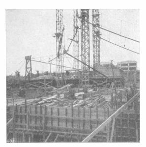
Abb. 33. Gussbeton-Verteilanlage eines Eisenbeton-Baues.
