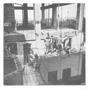
Abb. 34. Fassaden-Ausmauerung von Hänggerüsten aus.
