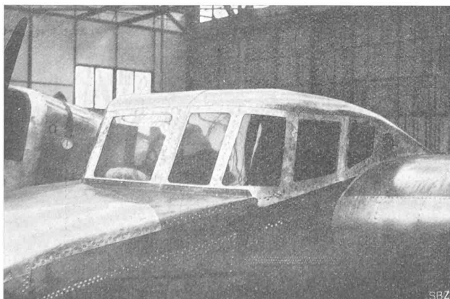
Abb. 10. Geschlossene Führer-Kabinen des Zeppelin-Flugzeuges.
