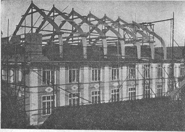
Stockwerksaufbau einer Fabrik nach Hetzer'scher Bauart.
