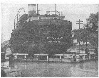
Abb. 6. Schleuse bei Thorold im kanadischen "Welland-Kanal". Länge 85 m, Breite 14 m, Drempeltiefe 4,4 m. Hölzerne Stemmtore.
