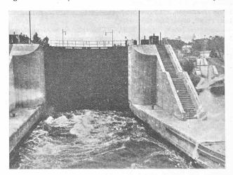
Abb. 3. Normale Stemmtor-Schleuse des New York Barge-Kanals. Rechts im Hintergrund die Schleusentreppe des alten Erie-Kanals.
