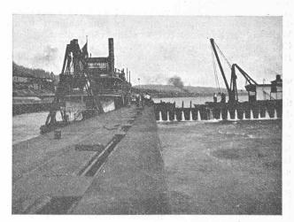
Abb. 4. Schleuse und Klappenwehr im kanalisierten Ohio. Schleusen-Länge 183 m, Breite 33,6 m, Drempeltiefe 3,35 m.
