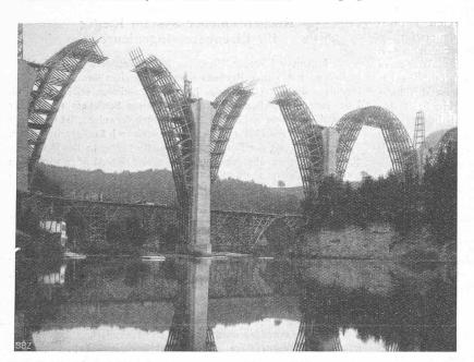
Abb. 1. Gerüste der Pérolles-Brücke in Freiburg. — Aufnahme vom 20. September 1921.
