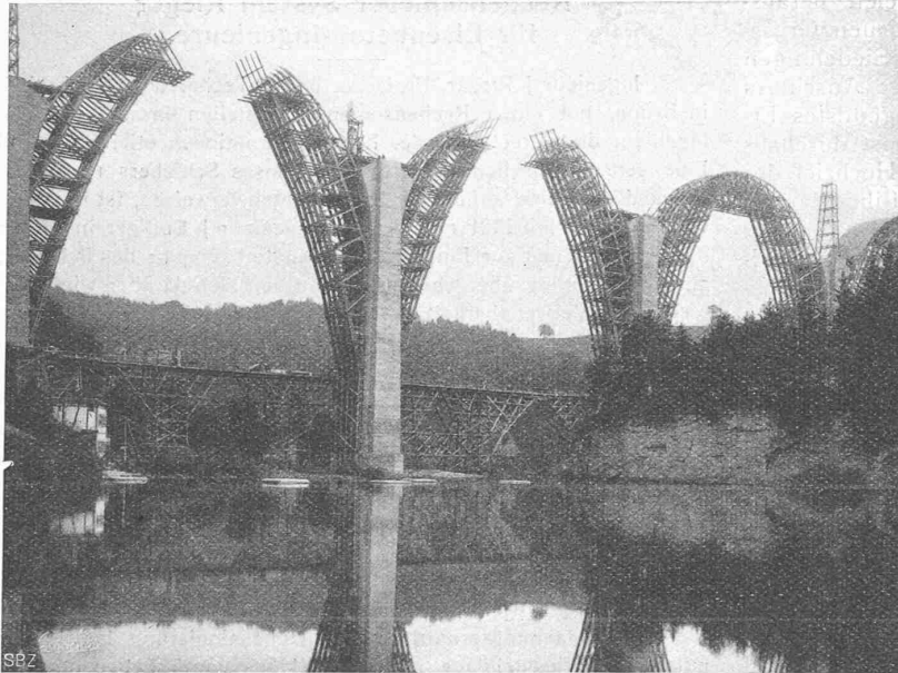
Abb. 1. Gerüste der Péroles-Brücke in Freiburg. — Aufnahme vom 20. September 1921.
