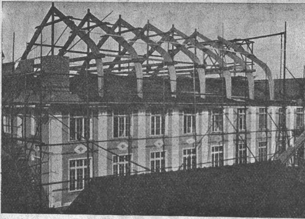
Stockwerksaufbau einer Fabrik nach Hetzer'scher Bauart.
