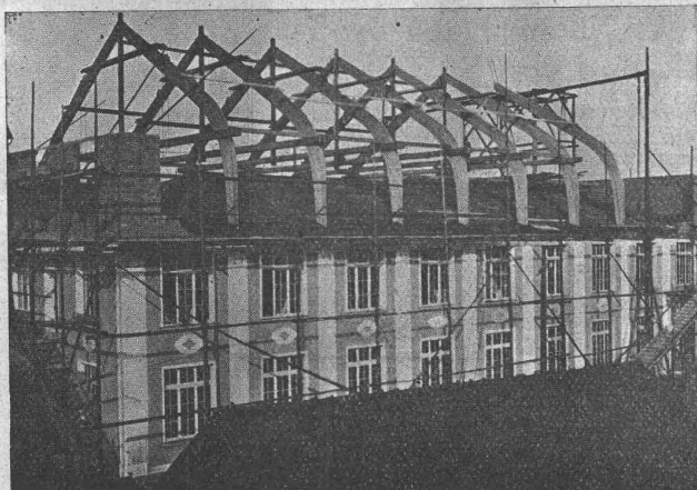
Stockwerksaufbau einer Fabrik nach Hetzer'scher Bauart.
