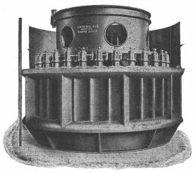
Einrad-Francis-Schnelläufer mit vertikaler Welle und aussenliegender Regulierung, Gefälle 4,8 bis 6 m, Leistung 1240 bis 1650 HP.
