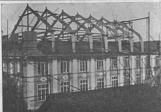
Stockwerksaufbau einer Fabrik nach Hetzer'scher Bauart.
