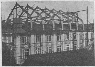
Stockwerksaufbau einer Fabrik nach Hetzer'scher Bauart.
