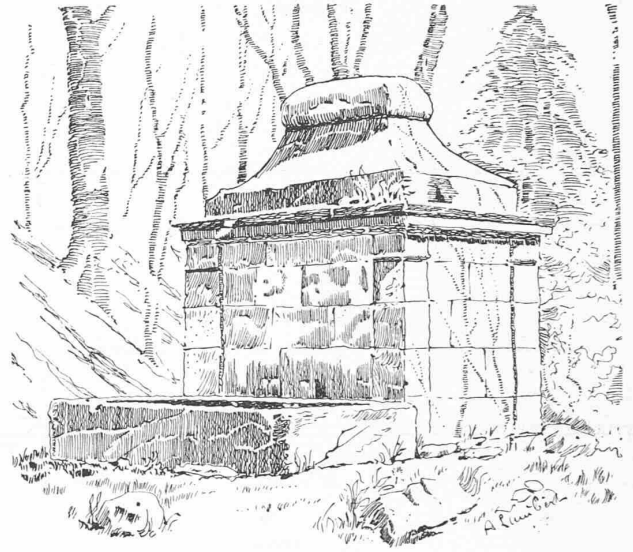
Fig. 2. Le puits Godet à Pierre-à-Bot près de Neuchâtel.
