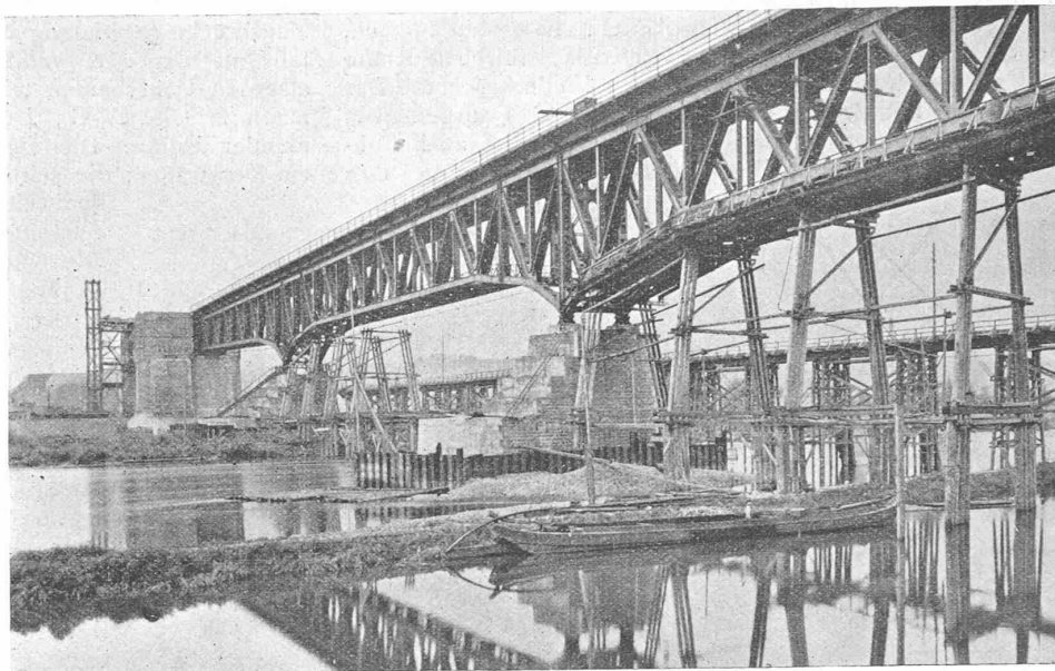
Abb. 7. Brücke über die Maas bei Visé. (Mittelöffnung von 93,00 m mit zwei Seitenöffnungen von je 75,50 m Weite.) Dahinter die Hilfsbrücke für den Erdtransport.
