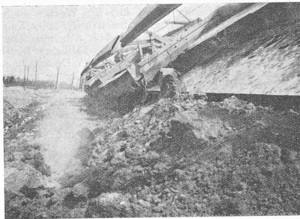
Abb. 54. Gekippter Materialzug in der Deponie.
