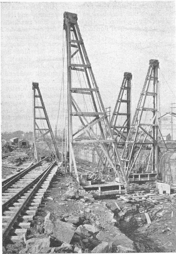
Abb. 38. Arbeitsvorgang (zweite Etappe) für den Kanal im Erd-Fels-Profil. Die Brunnen-Bohrgruppe beim Erstellen der Randlöcher.
