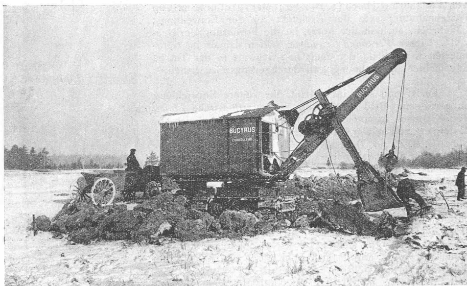
Abb. 31. Kleinsten elektrischer Löffelbagger, auf Radgürtel, der Hydro Electric Power Commission of Ontario. Fassungsvermögen des Löffels in Erde 0,7 m 3 .
