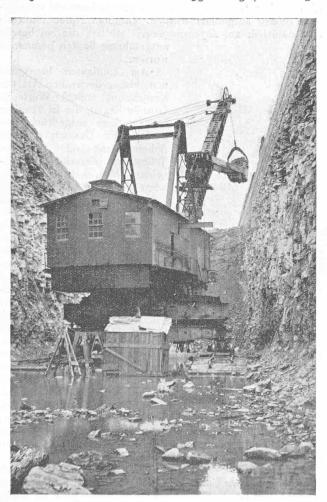
Abb. 24. Elektrischer Löffelbagger Typ 225 B, im Fels arbeitend. Fassungsvermögen: in Erde 6 m³ bei 50 sek Spiel, in Fels 3,8 m³ bei 80 sek Spiel.
