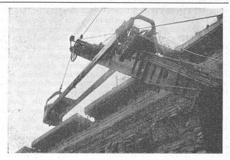
Abb. 25. Bagger-Typ 225 B beim Entladen auf die Bahnwagen.
