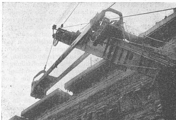
Abb. 25. Bagger-Typ 225 B beim Entladen auf die Bahnwagen.
