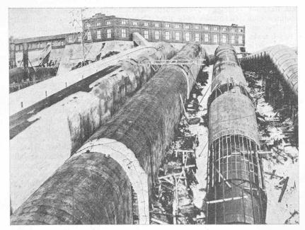
Abb. 9. Temperatur-Schutzhüllen aus "Gunite" auf Drahtgeflecht über den Druckleitungsrohren der Shawinigan Water and Power Co., Ontario, Kanada.
