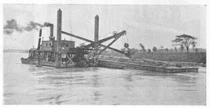
Abb. 21. Schwimmender Löffelbagger mit Dampfbetrieb. Löffelinhalt 3,8 m3,
