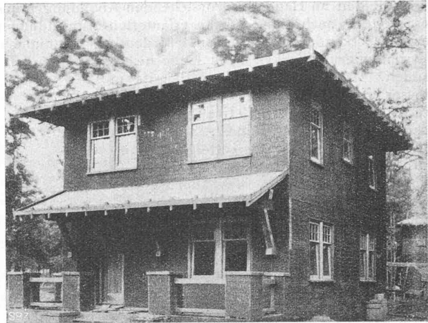
Typisches amerikanisches Einfamilienhaus einer Vorstadtzone in leichter Holzkonstruktion mit äusserem Zementüberzug. Abb. 10. Vor Anbringung der äusseren Verkleidung.
