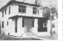
Abb. 12. Aehnliches Haus wie oben, fertig mit "Gunite"-Ueberzug.
