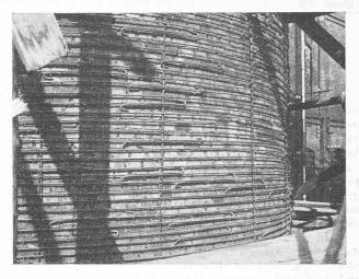
Abb. 13. Eisenarmierung über der Backstein-Verkleidung eines Oel-Behälters, vor Aufbringung des "Gunite"-Ueberzuges.
