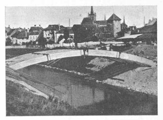
Abb. 12. Hetzer-Binder als Brücken--Lehrgerüstträger.
