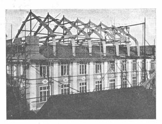
Abb. 11. Hetzer-Dachbinder über einer zu erhöhenden Fabrik.
