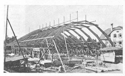
Abb. 14. Hallenbau mit Dreigelenk-Bindern nach System Thurnherr.
