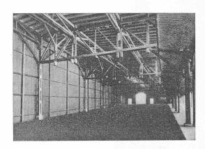
Abb. 6. Perron-Dach im Bahnhof Genf-Cornavin (System Locher & Cie.).
