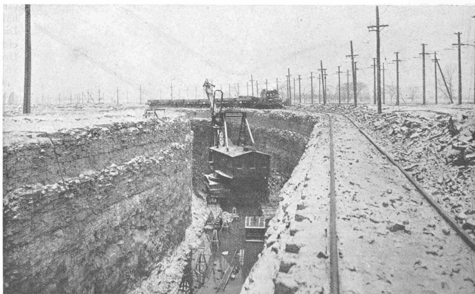
Abb. 12. Grosser Bagger in der Kanalkurve bei Km. 13,2. Erdüberlagerung des Kalkfelsens 0,3 m.
