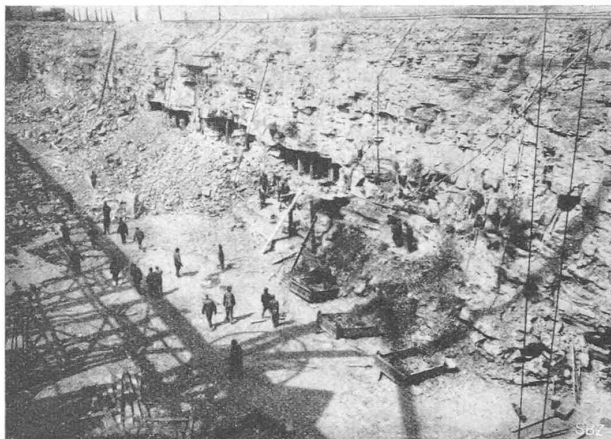
Abb. 14. Stolleneingänge in der Stirnwand des Wasserschlosses.
