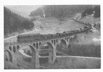
Abb, 6. Zug von 150 Achsen mit Kunze-Knorr-Güterzugbremse im Gefälle 1:30 auf der Strecke Neuhaus-Probstzella in Thüringen (19. II, 14).
