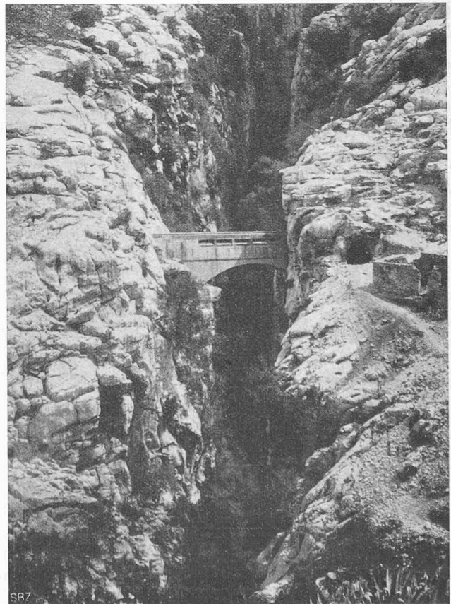
Fig. 13. Vue d'amont de l'aqueduc sur le Guadiaro.
