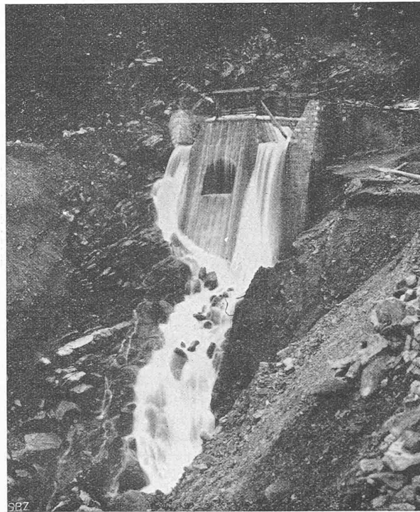
Fig. 18. Issue du déversoir et de la galerie de décharge dans l'Arroyo de Camilla.
