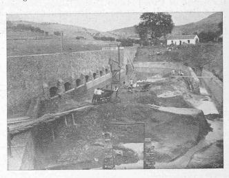
Fig. 11. Intérieur du bassin de décantation pendant sa construction.
