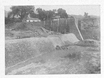
Fig. 10. Barrage et vannes de prise, en construction.
