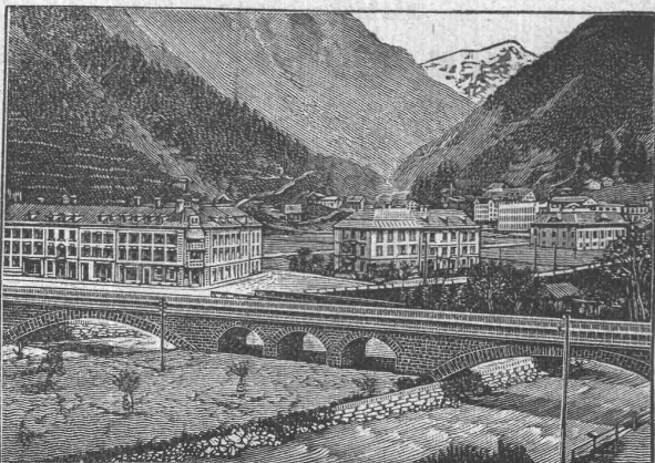
EISENBAHNBRÜCKE ÜBER DIE LINTH-UND-SERNFT-INSCHWANDEN
