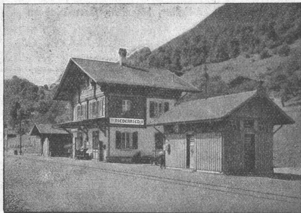
Station der Brienerseebahn. Eternit-Doppeldach, kupferbraun.
