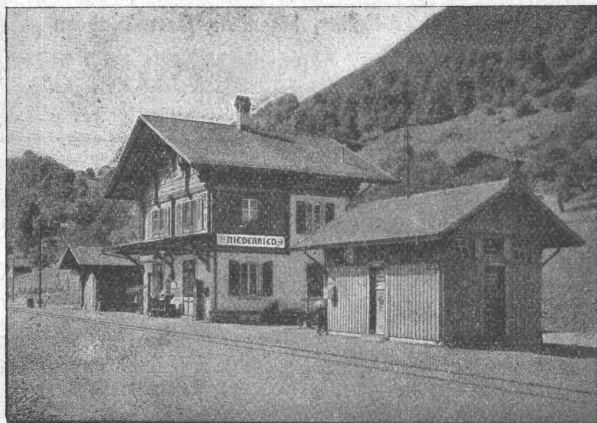
Station der Brienerseebahn. Eternit-Doppeldach, kupferbraun.
