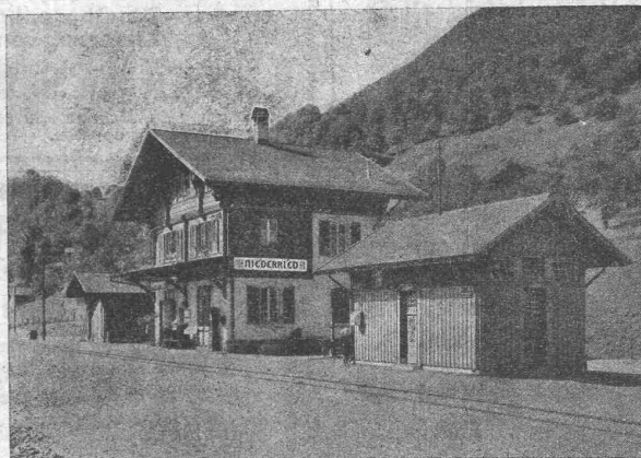
Station der Brienzerseebahn. Eternit-Doppeldach, kupferbraun.
