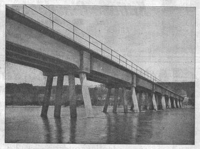
Eisenbahnbrücke über die Aare bei Däniken. Erste schweizerische Pfahljochbrücke in Eisenbeton. Eisenbetonpfahlrammungen
