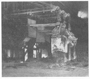
Abb. 5. Frühere Elektroden der Ofenanlage in Anniston.
