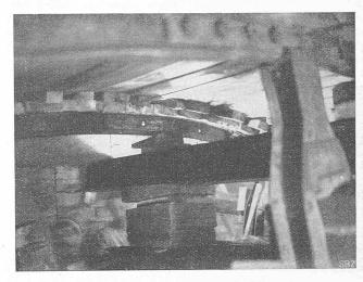
Abb. 6. Hilfsbau ("Esel") im Scheitel des Ausbruchs.
