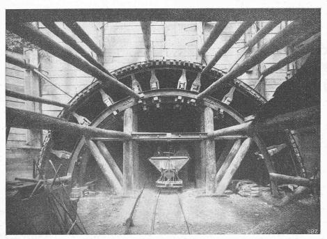
Abb. 2. Ausschachtung an Tunnelmündung mit Kunz'scher Rüstung.
