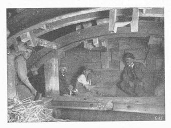
Abb. 5. Sicherung der Brust im Scheitel des Ausbruchbogens.
