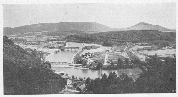
Abb. 1. Blick auf die korrigierte Aarestrecke flussabwärts der neuen Hauensteinlinie mit Stauwehr und Kanaleinlauf des Kraftwerks "Gösgen".
