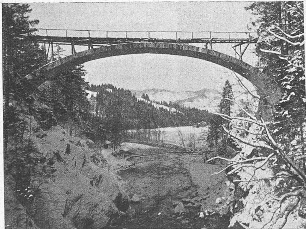
Abb. 21. Ausgeschaltetes Gewölbe der Klusstalden-Brücke während des Winters.
