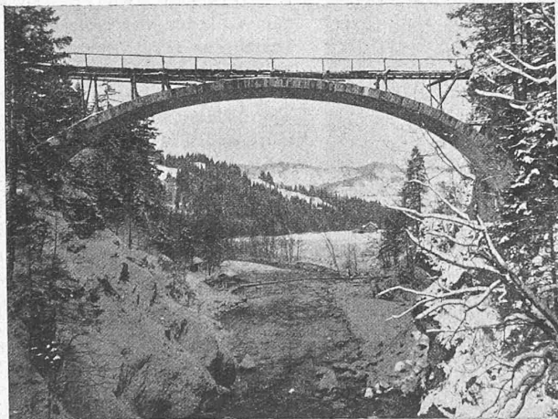
Abb. 21. Ausgeschaltetes Gewölbe der Klusstalden-Brücke während des Winters.
