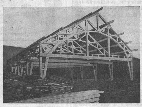
Bau in Zofingen für Widmer Söhne. Zweigelenkbinder mit aufgehängterDecke
