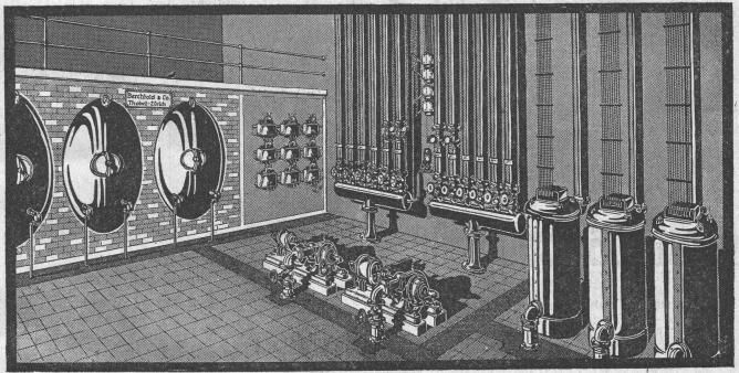
Pumpen- und Schwerkraft-Warmwasserheizungen mit elektrischer Wärmeerzeugung mit und ohne Wärme-Akkumulierung zur Ausnützung billiger Nachtkraft.
