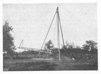
Abb. 2. Aufstellung eines Mastes der Freileitung.
