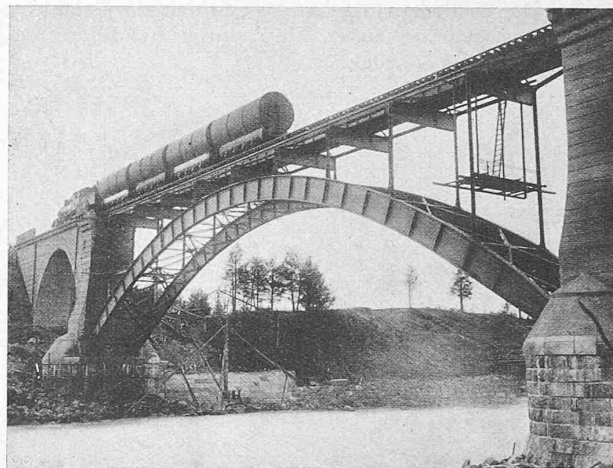
Abb. 16. Vollwand-Zweigelenkbogen von 55,8 m über den Pite-Fluss.
