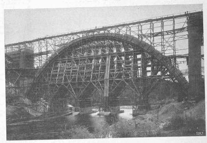
Abb. 18. Lehrgerüst (am 14. Juli 1918) für den 90,70 m weit gespannten Eisenbeton-Bogen einer normalspurigen Eisenbahn Brücke über den Oere-Fluss in Schweden.
