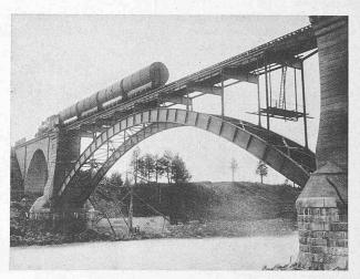
Abb. 16. Vollwand-Zweigelenkbogen von 55,8 m über den Pite-Fluss.
