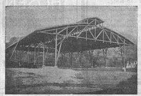
Reingelenkartig wirkende, elastisch arbeitende Holzkonstruktionen. Das Schwinden und Quellen (Arbeiten) des Holzes vollzieht sich spannungs-- Keine Materialüberbeanspruchungen. Kostenersparnisse.
